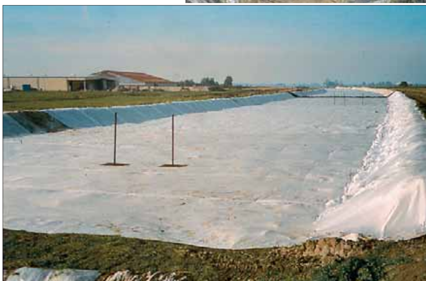
Армирование насыпи окружной дороги материалом Stabilenka® 300/45
