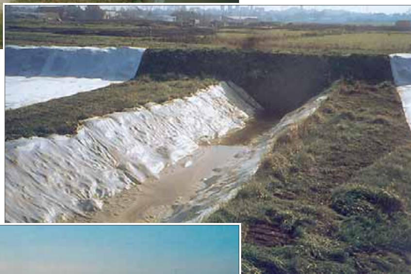
Дополнительное армирование водоотводной канавы
