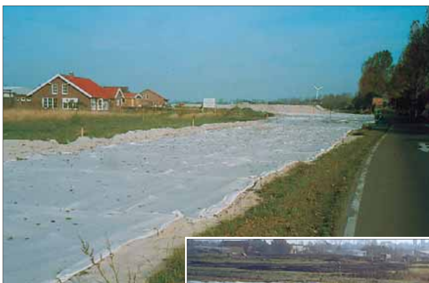
Армирование материалом Stabilenka® 150/45 подъезда к окружной дороге г. Йевер
